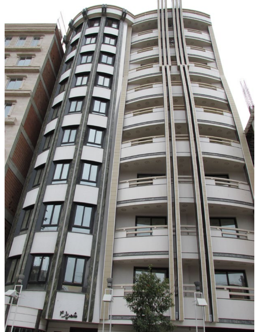
ساختمان مسكونه شهریار ۴ سارم، خیابان شهابه
